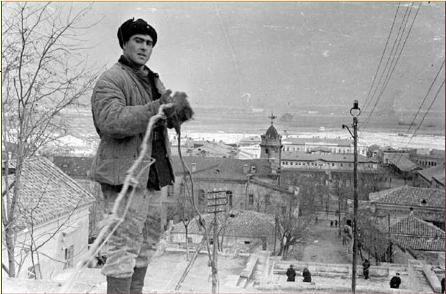
Керчь. Митридатская лестница. Восстановление линий электропередачи (январь 1942г.)
